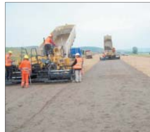
Lucrările la autostrada Transilvania
